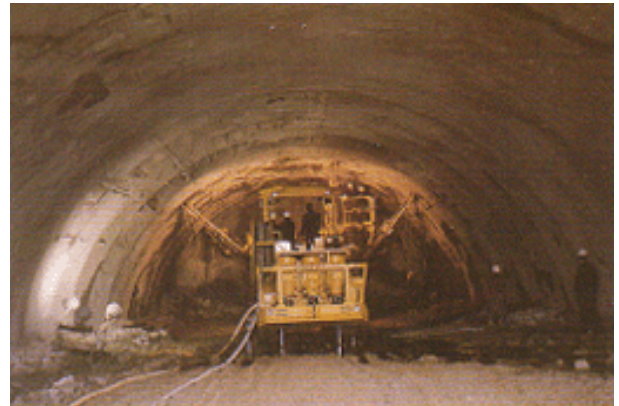
Rock Bolt를 삽입할 구멍 뚫는 장면
