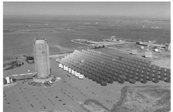
[그림 10] 타워형 태양열 집열시스템(미국샌디아국립연구소)
