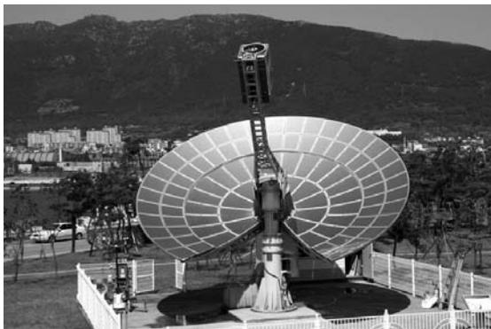
[그림 9] 접시형 태양열 집열시스템(한국에너지기술연구원)
